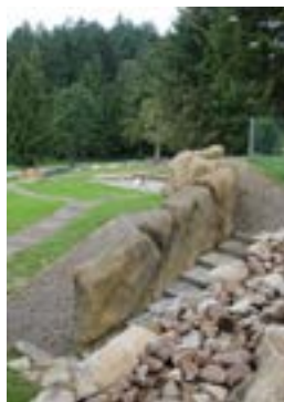
Kletterwand als Hangsicherung - Badische Staatsbrauerei Rothaus
