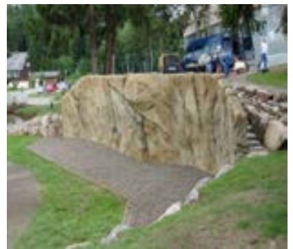
Kletterwand als Hangsicherung - Badische Staatsbrauerei Rothaus
