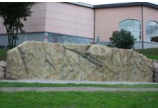
Kletterwand als Hangsicherung - Badische Staatsbrauerei Rothaus
